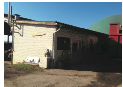
Das Bild zeigt eine Biogasanlage in Marthalen, welche vom Bauern Martin Wipf betrieben wird. Im Rahmen der Bachelorarbeit soll eine Aufbereitungsanlage für diesen realen Standort untersucht und konstruiert werden.
