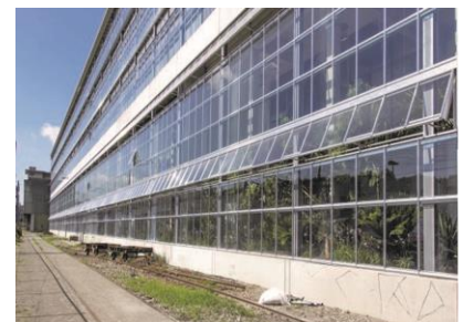
Das Gebäude 181 in Winterthur auf dem Lagerplatz 21 wurde vor zwei Jahren renoviert. Teil der Renovation war der Anbau einer gläsernen Doppelfassade in welcher Pflanzen aufgestellt wurden.
