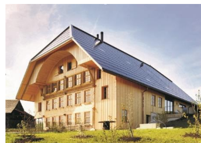
Historisches Gebäude mit GiPV
