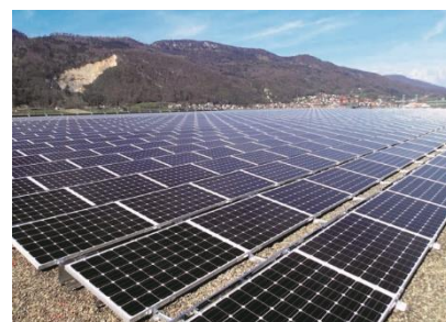
Photovoltaikanlage im industriellen Massstab in Neuchâtel.
