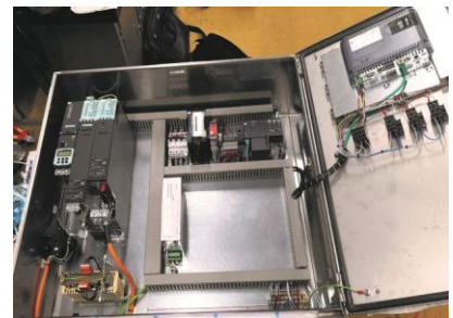
Der Schaltschrank enthält den Steuer- sowie den Leistungsteil für die Achsansteuerung. Die Bedienung erfolgt über ein HMI in der Tür.
