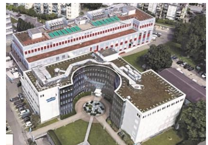
Der Firmensitz von Meier Tobler in Schwerzenbach mit dem verglasten Gebäude A und dem Gebäude B im Hintergrund.
