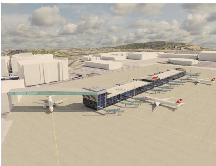
Westansicht des Docks Süd am Flughafen Zürich – auf dem Dach sind die Landeplätze für die Passenger Air Vehicles zu sehen. Die Passagierbrücke verbindet das Dock Süd mit dem bestehenden Flughafen.
