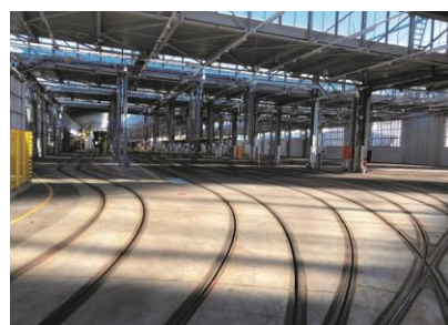
Innenansicht des Betriebshof Wollishofen (eigenes Bild)
