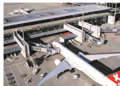
Terminal Flughafen Zürich (Quelle: https://www.suedostschweiz.ch/wirtschaft/2021-01-15/flughafen-zuerich-verschiebt-neubauten-von-dock-a-und-terminal-1 )
