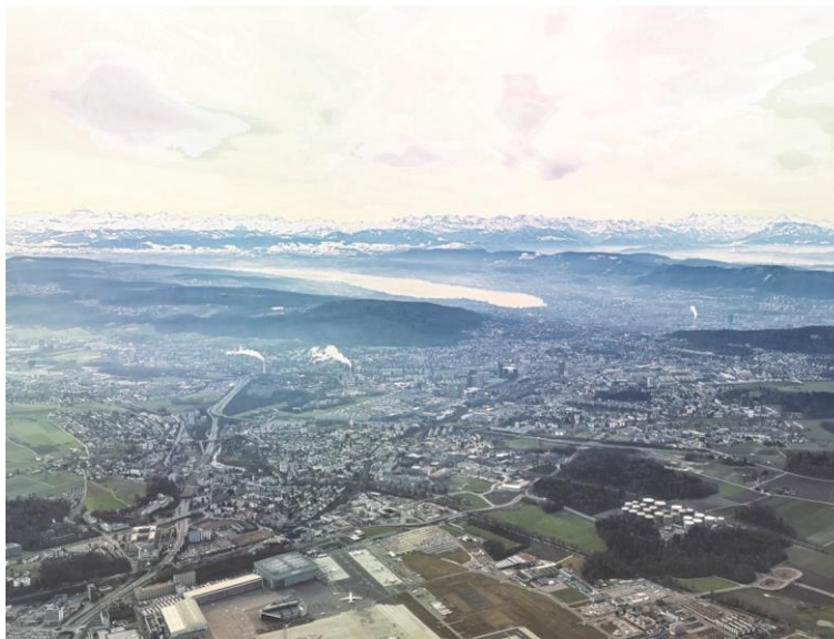
Der Flughafen Zürich mit der angrenzenden Industrieregion und der Stadt Zürich
