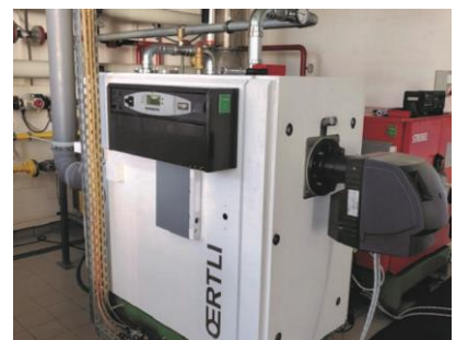
Feuerungsanlage für den Einsatz der Wasser-Diesel-Emulsion
