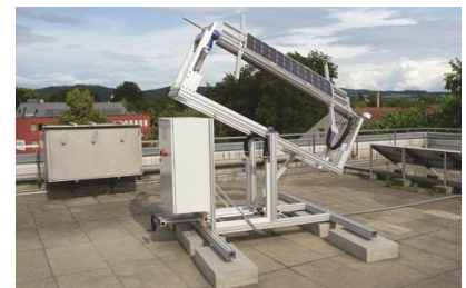
Das Bild zeigt den Fast Solar Module Tracker, bestehend aus dem Grundgerüst, auf dem die drehbare Tagesnachführung montiert ist. Das Solarpanel wird während der Messungen von parallelem Lichteinfall in die Position mit senkrechtem Lichteinfall gedreht.
