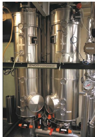
Verwendete Adsorber der Pressure-Swing-Adsorptions-Pilotanlage.
